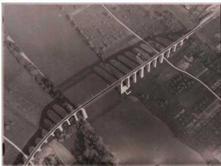
Robert Petschow, Viadukt von Eglisau in der Schweiz in der Morgensonne, um 1930, © Urheberrechte am Werk erloschen
