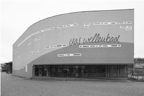
Berliner Architekturen der 1980er Jahre - Audiowalk Route 2, Wiener Straße 59h (Spreewaldplatz): Spreewaldbad, Christoph Langhof, Foto: © Ludger Paffrath
