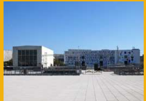
Dachterrasse des La Friche la Belle de Mai © IBK, Matthias Pätzold
