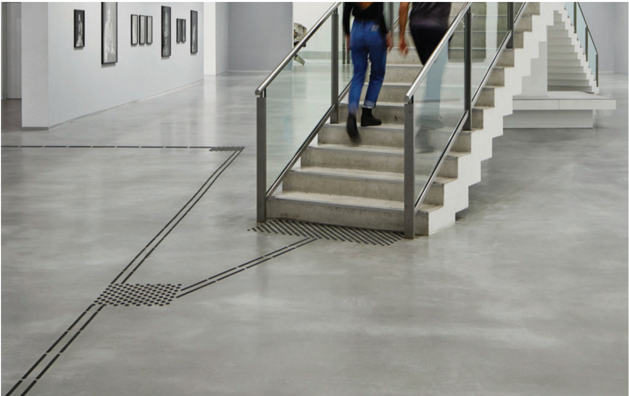
Taktiler Bodenleitsystem zum Treppenaufgang
